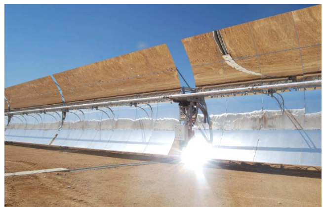
Figure 3: Planta Solar Termoeléctrica en Puertollano (50 MW); Inversión: 28 M€; Producción Neta Estimada: 41 GWh/y
